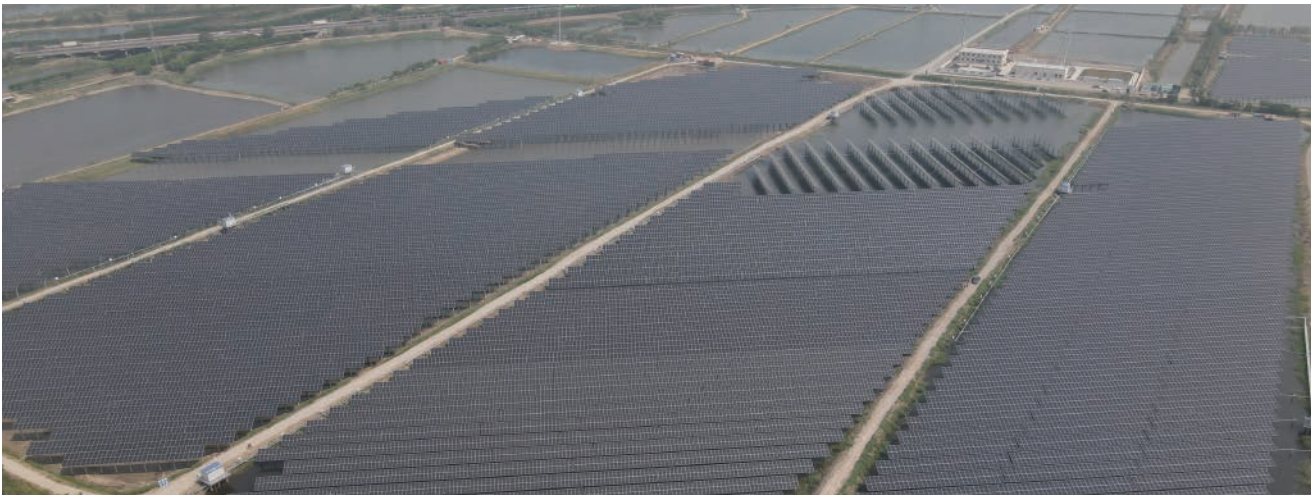
天津渔光互补项目 安装时间： 2024
