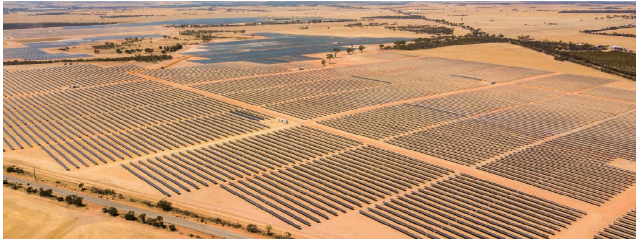
澳大利亚地面电站项目 安装时间： 2020
